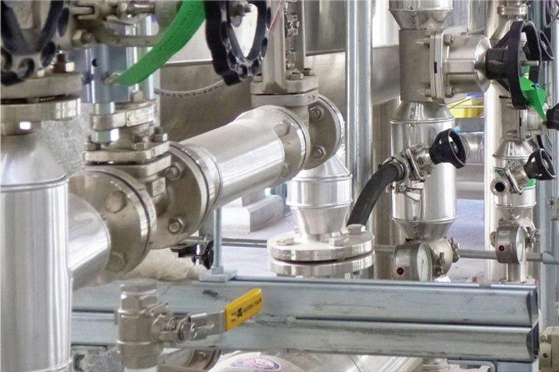
Imagen 3. En la industrial de Ciencias de la Vida, el simple hecho de extraer un sensor puede ser un inconveniente debido al número de equipos colindantes y la necesidad de mantener la limpieza.
